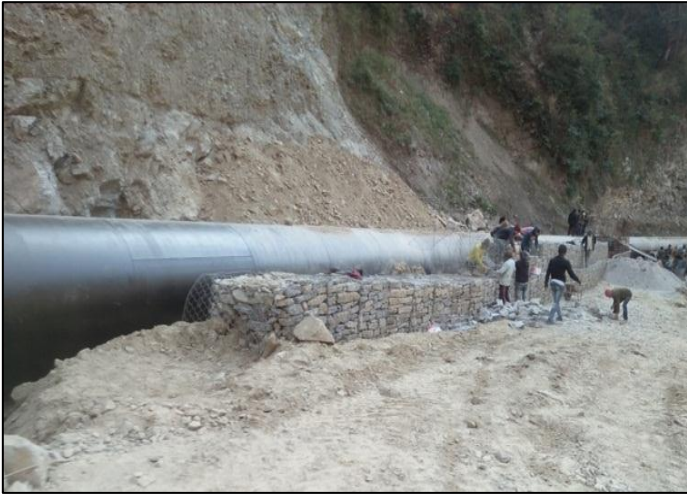
पेनस्टक पाइपको protection को लागि Gabion Wall लगाईदै
