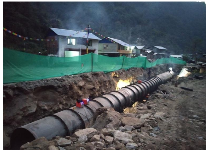
बरु गाउँमा पेनस्टक पाइप Erection गरिदै
