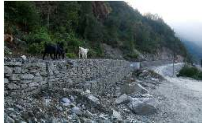
पेनस्टक पाईपलाई gabion लगाई सुरक्षा गरिएको
