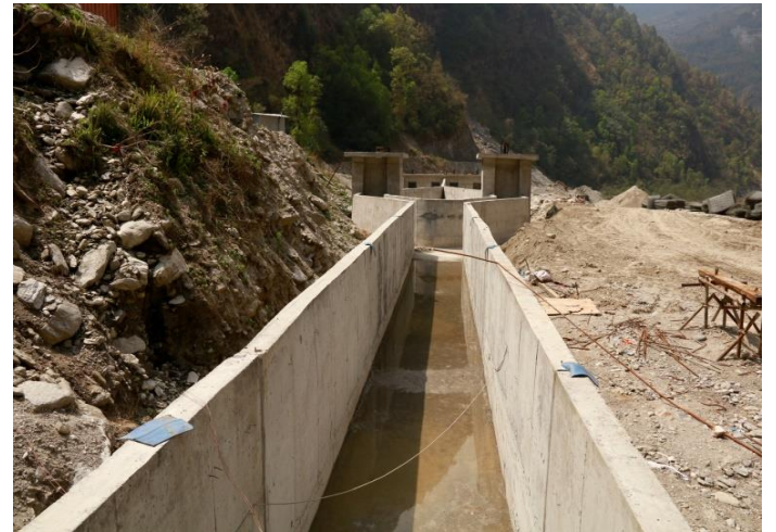
कनेक्टीड क्यानलको निर्माण सम्पन्न ।
