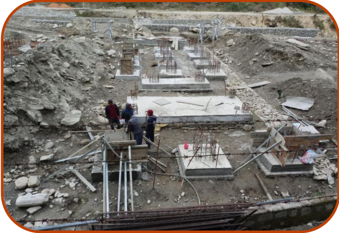
सिंगटी सब स्टेशनमा Inter Connection Bay को कार्य प्रगति।
