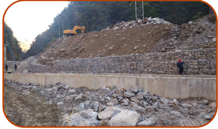
पावर हाउसमा Drainage Cable Trench र Protection को कार्य गरिदै।
