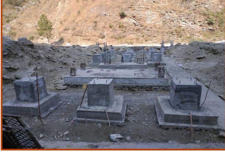
Singati Substation को निर्माण कार्य भईरहेको ।
