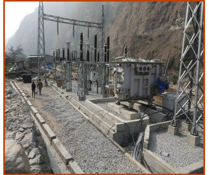
Power Switch yard को कार्य प्रगति ।
