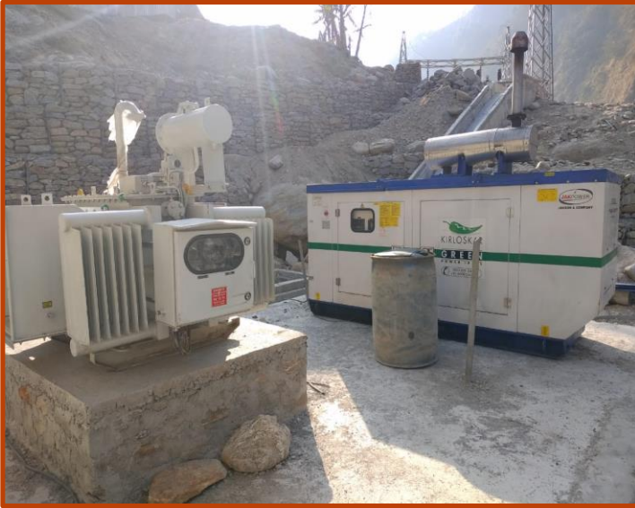
Auxillary Transformer र Generator installation कार्य सम्पन्न भईसकेको ।
