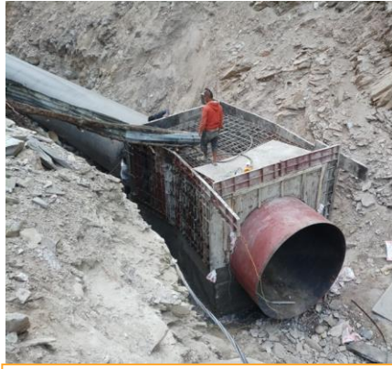
Anchor block no.2 को ढलान गरिदै
