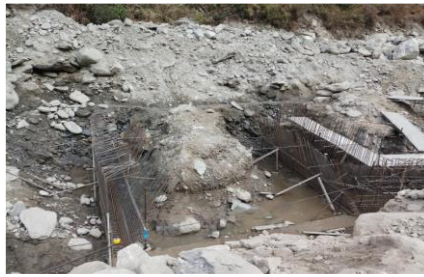
निर्माणाधीन अन्डर स्लुइस
