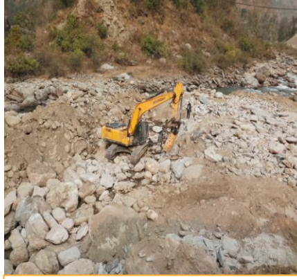
पावर हाउस Excavation
