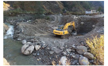
साइफन निर्माणको लागि Excavation
