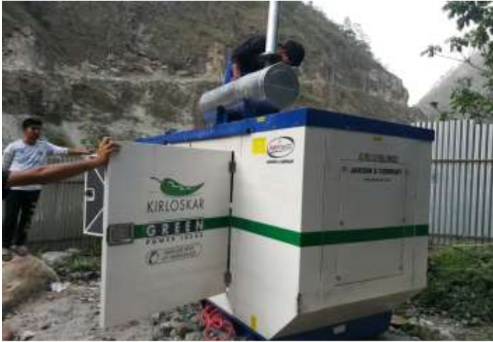
Electro Mechanical कम्पनीले Supply गरेको डिजेल जेनेरेटर
