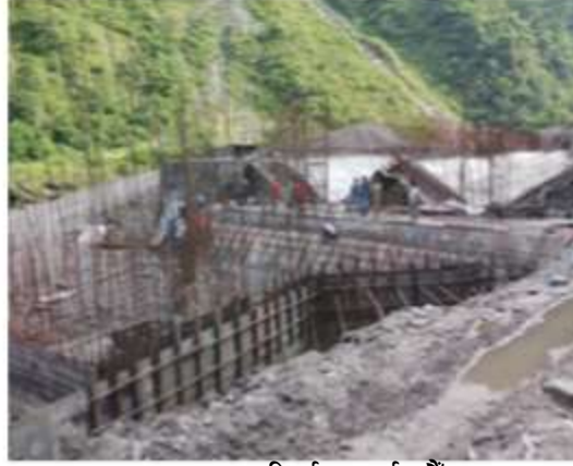
Forebay निर्माण कार्य हुँदै
