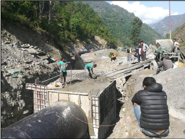
पेनस्टक पाइप Erection
