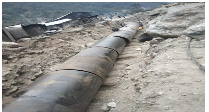
पेनस्टक पाईपको erection हुदै
