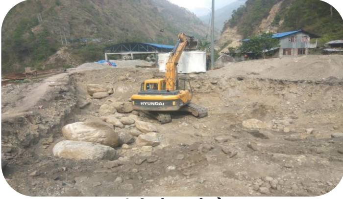
Substation को निर्माण कार्य हुदै ।
