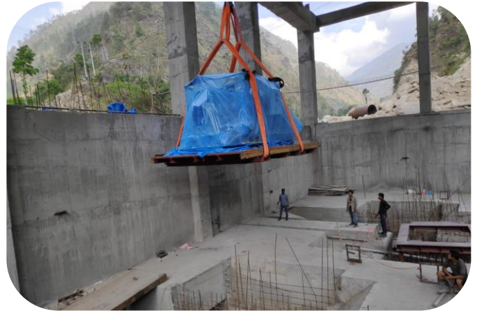
पावर हाउसमा Generator Unload गरिदै ।
