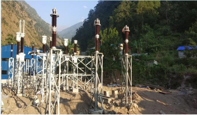
पावर हाउसको सब स्टेशनमा इलेक्ट्रोमेकानिकल सामानहरु जडान गरिदै ।
