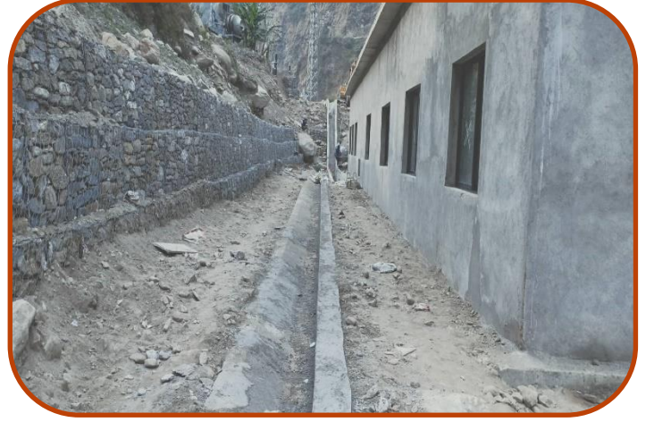
पावर हाउसमा Drainage Cable Trench र Protection को कार्य गरिदै।
