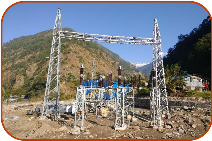
पावर हाउसको सब स्टेशनमा इलेक्ट्रोमेकानिकल सामानहरु जडान गरिदै।
