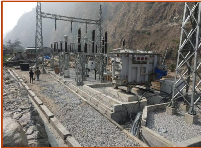
Power House Switch yard को कार्य प्रगति
