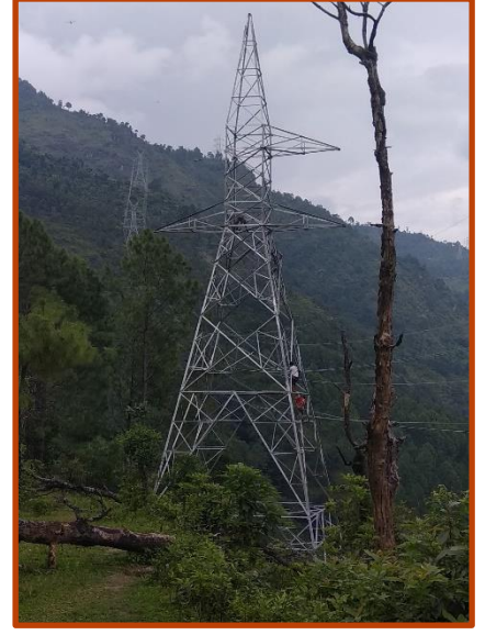
Tower erection को निर्माण कार्य ।
