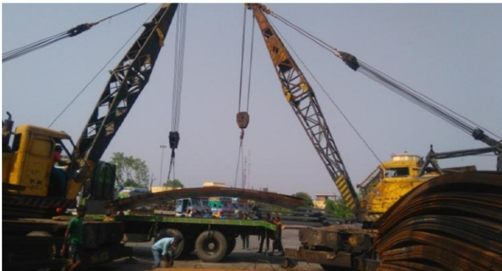
सुक्खा बन्दरगाहमा स्टील प्लेट लोड गरिदै
