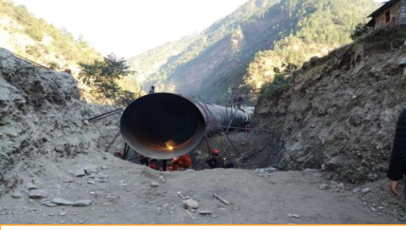
पेनस्टक पाइप erection को एक दृश्य
