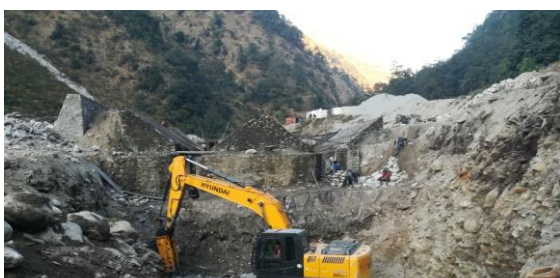
फोर-वे निर्माणका लागि excavation गरिदै
