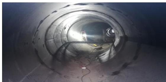
पाइपहरू erection गर्ने कार्य गरिदै
