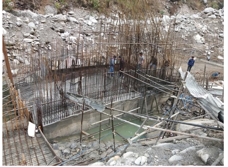
निर्माणाधीन अण्डर स्लुइस
